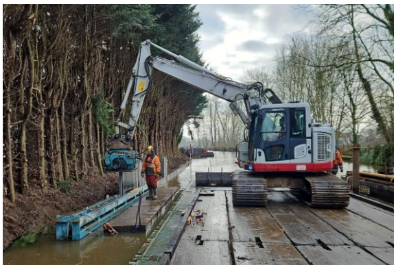
Figuur 8: Aanbrengen nieuwe oeverconstructie bij project kadeverbetering Willeskop
