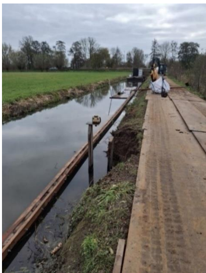
Figuur 7: Uitvoering van het herstel van de Houtdijkkade
